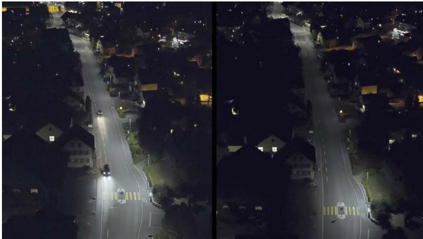
Abb. 33: das verkehrsbeobachtende Licht in Urdorf (CH): Je nach Verkehrsaufkommen verändert sich die Beleuchtungsstärke zwischen 100 % (links) und 40 % (rechts).
