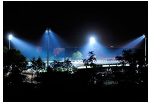
Im Bild sind Strahler des FSV-Stadions in Frankfurt mit Metallhalogenid-Hochdrucklampen zu sehen. Die ursprünglich stark vorhandene Streustrahlung in die Umgebung konnte mit Ausblendrastern deutlich reduziert werden. Die Sichtbarkeit auf weite Distanz ist dennoch gegeben.
